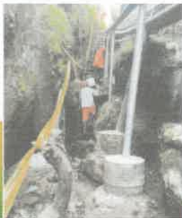
OBRA EN EJECUCIÓN
