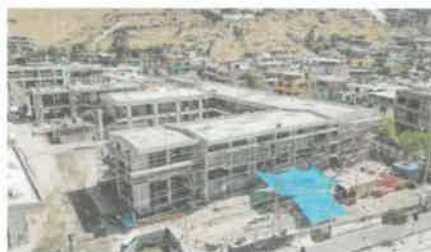
OBRA EN EJECUCIÓN
