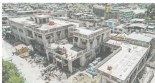
OBRA EN EJECUCIÓN
