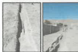
Ejecución de mantenimiento: - Malla 1: 100% completado - Malla 2: 50% ejecutado
