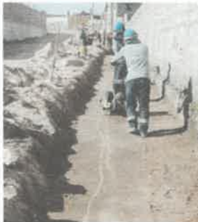
OBRA EN EJECUCIÓN
