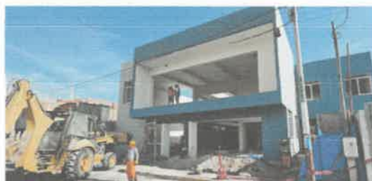
OBRA EN EJECUCIÓN
